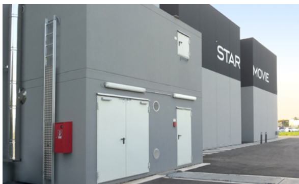
Doppelstock-Heizmodul 200 kW Hackgut, Gewerbe
