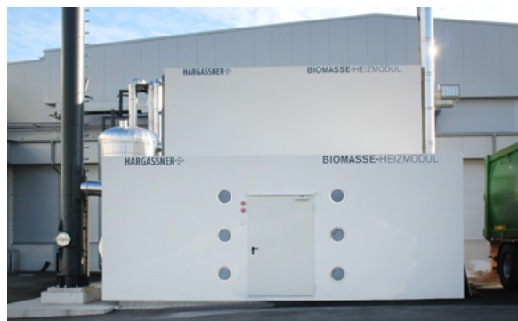
Mehrfach-Heizmodul 660 kW Hackgut, Industrie
