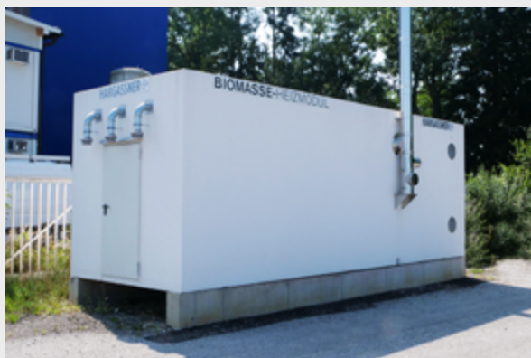
Einstock-Heizmodul 120 kW Pellets, Gewerbeobjekt
